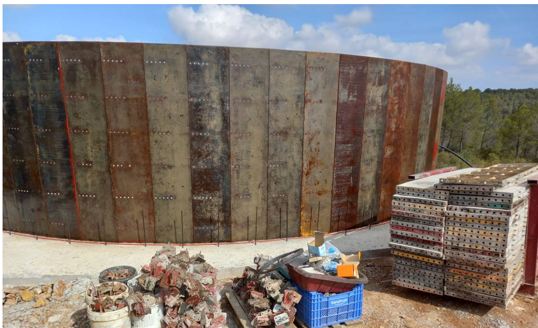
Imatge 7: Exemple d'encofrat en el punt d'aigua d'Avinyonet (PPP Garraf).
