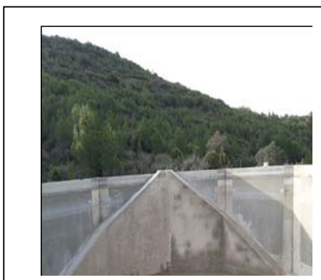
Imatge 10: Rampa de fauna d'obra per punt d'aigua.
